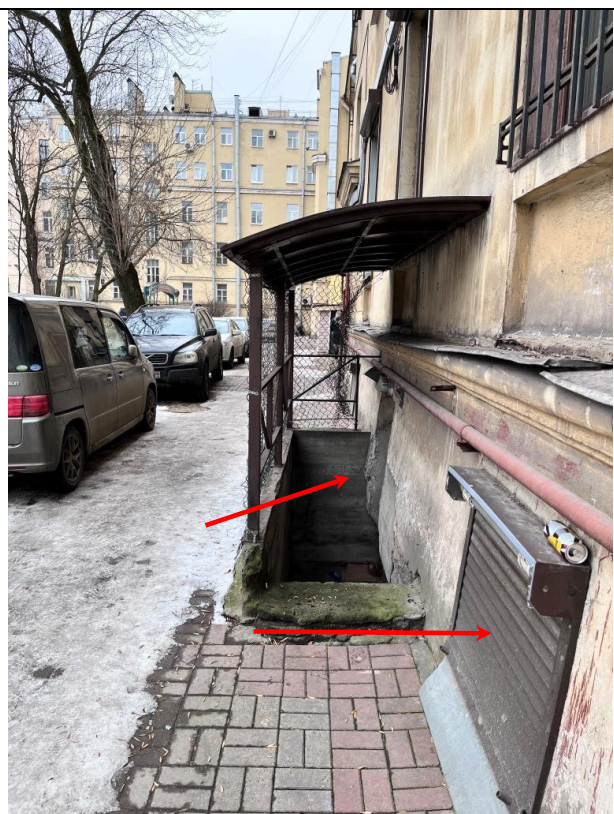
Фото 12. Входная и оконная группа Объекта оценки
