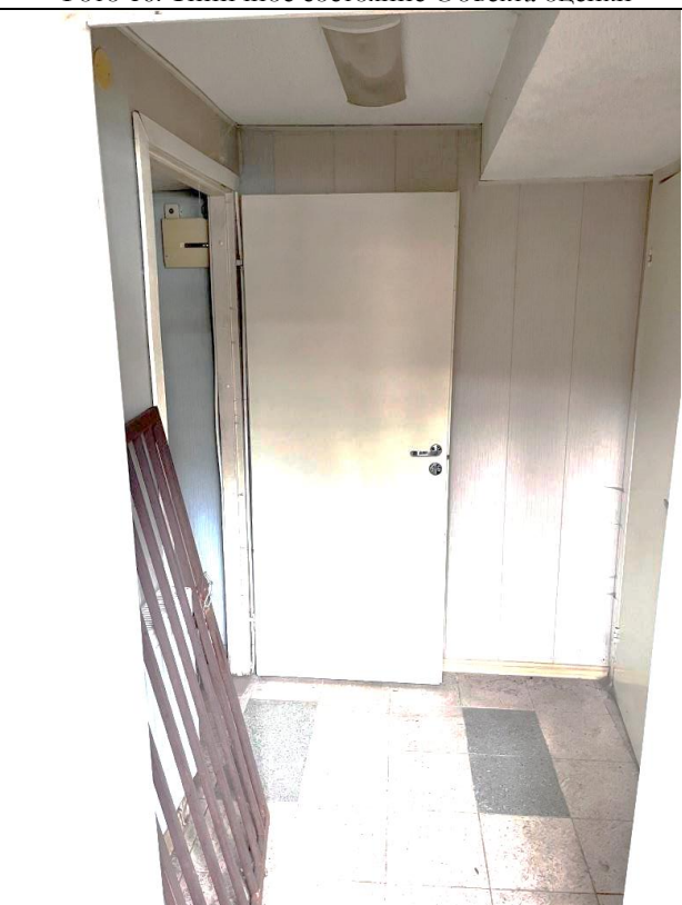
Фото 18. Типичное состояние Объекта оценки
