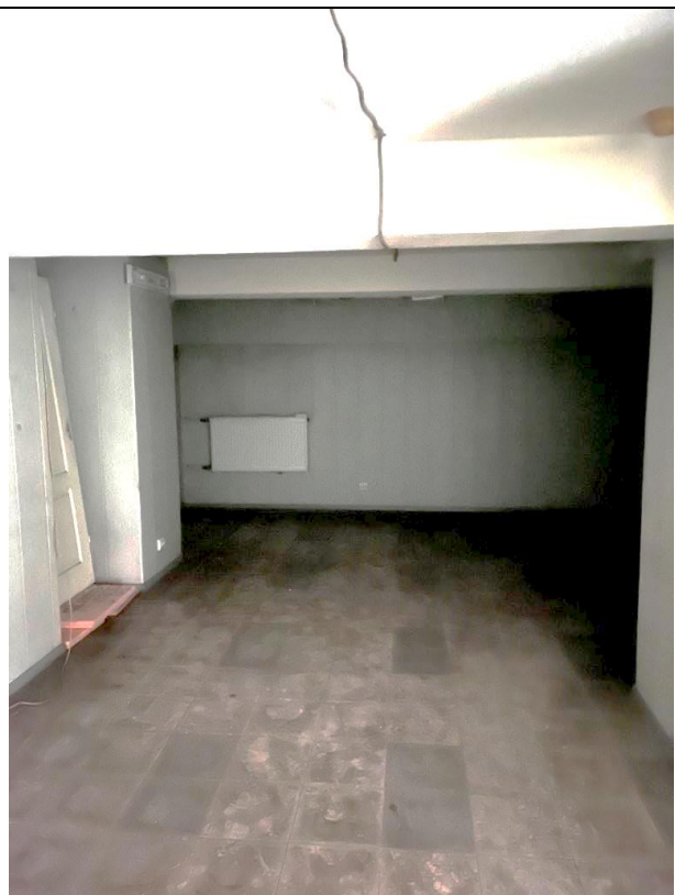
Фото 20. Типичное состояние Объекта оценки
