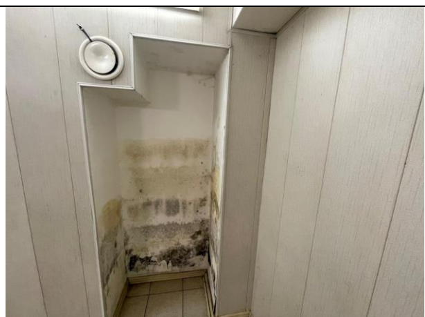
Фото 26. Типичное состояние Объекта оценки
